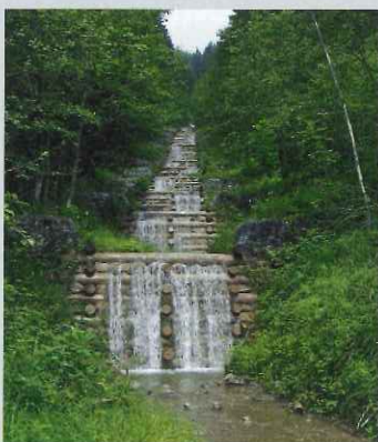
Bachverbau mit Holzsperrn in den Gamser Wildbächen (St. Gallen).
